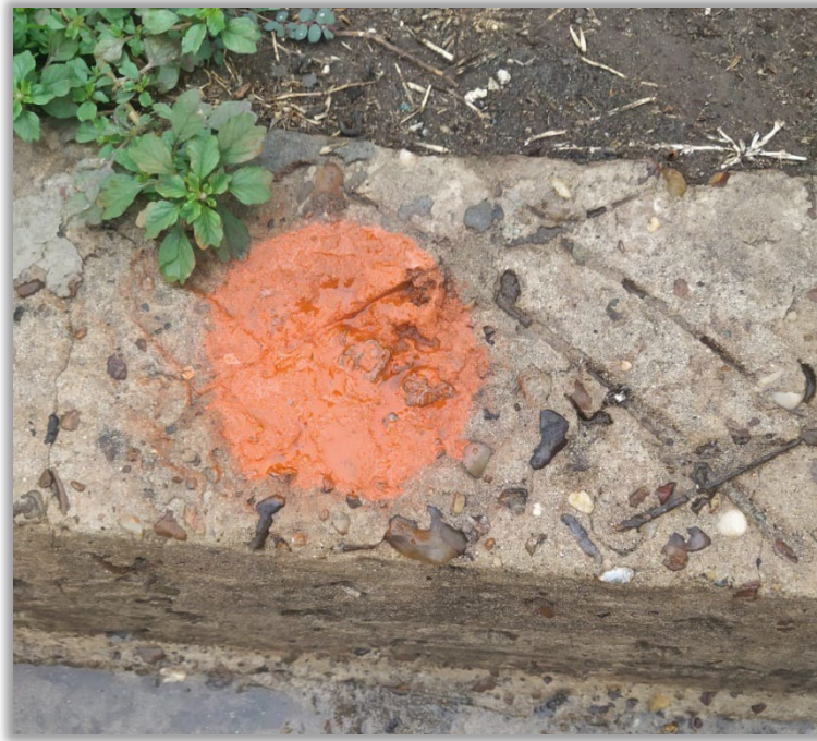
Figura 9: Materialización del punto fijo.
