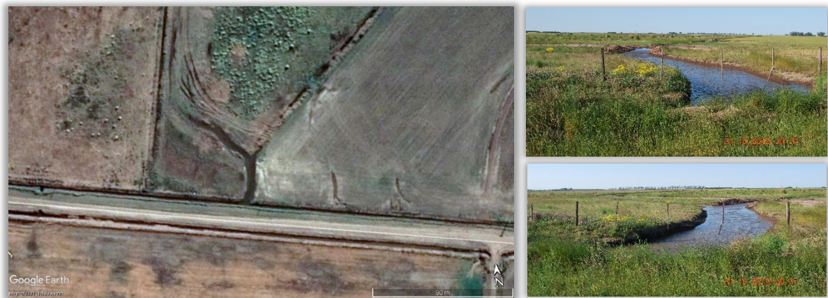
Figura 12: Canales con gran tránsito de agua.
